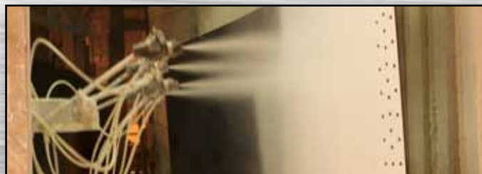
Etapa 2: Se revisten los paneles con el revestimiento vitreo Vitrium
